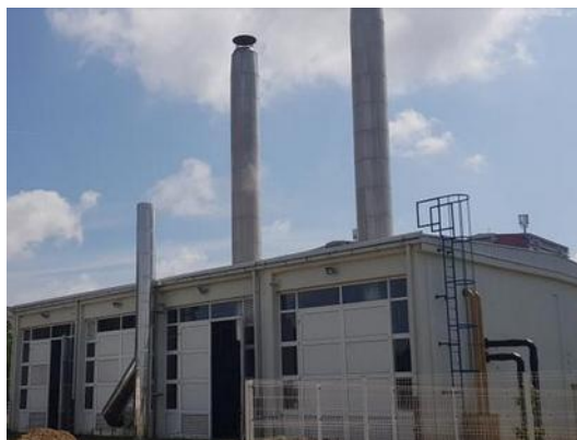
Sl. 3-14: Izvedba novog dimnjaka za kondenzacijski kotao u kotlovnici
