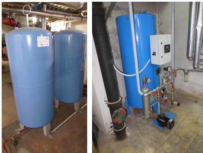
Sl. 3-28: Ekspanzijska posuda (lijevo) i ekspanzijski uređaj (desno)
