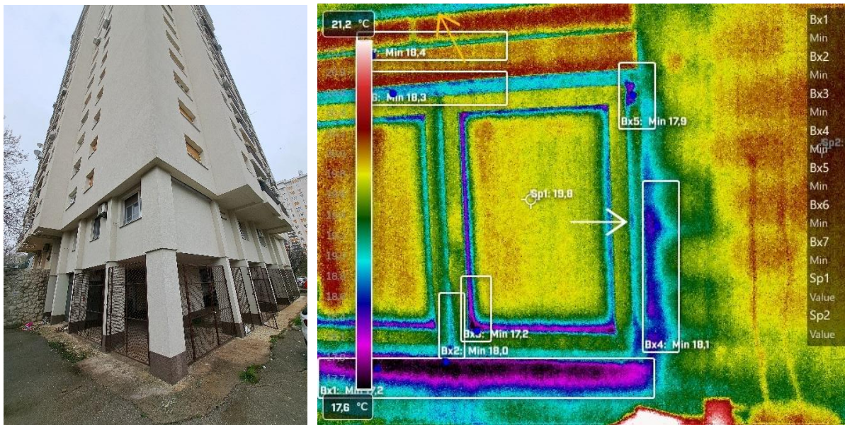
Sl. 2-8: Primjer zgrade u kojoj je napravljena loša procjena sastava građevnih dijelova zgrade
