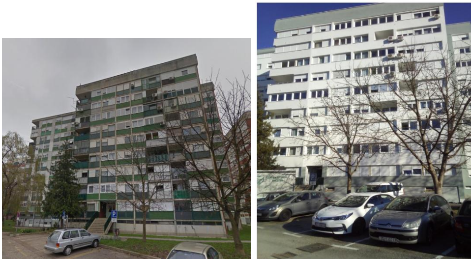
Sl. 2-2: Primjer stambeno-poslovne zgrade u Velikoj Gorici (HR-10410-0327-1) prije (lijevo) i nakon energetske obnove (desno)
