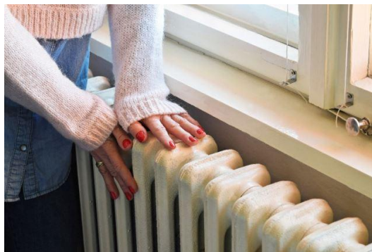
Sl. 3-32: Kod nedostatnog protoka ogrjevnog medija kroz ogrjevno tijelo, njegov učinak će biti manji, a grijanje prostora nezadovoljavajuće
