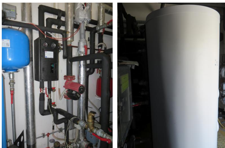
Sl. 3-18: Korištenje energije Sunca za pripremu PTV
