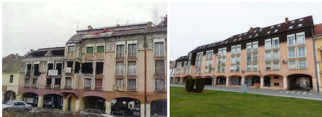
Sl. 2-1: Primjer stambeno-poslovne zgrade u Vukovaru (HR-32000-0096-1), oštećene u Domovinskom ratu (lijevo) i nakon provedene obnove (desno)
