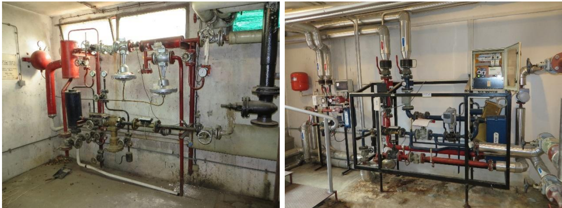
Sl. 3-26: Starija toplinska podstanica direktnog tipa (lijevo) i novija indirektna KOMPAKT toplinska podstanica (desno)
