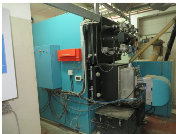
Sl. 3-15: Kotao na biomasu u prostoru nekadašnje uljne kotlovnice
