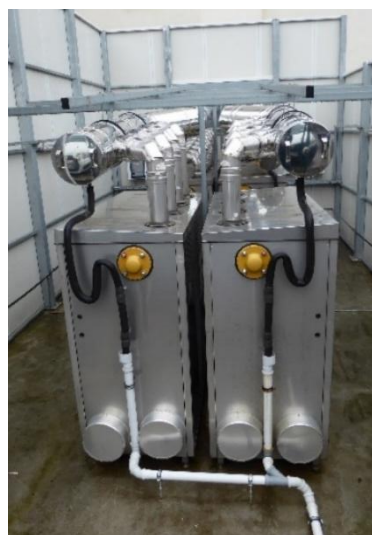
Sl. 3-24: Kotao na biomasu u kotlovnici višestambene zgrade u Vukovaru (lijevo) i modularni kondenzacijski plinski kotao toplane u Rijeci (desno)
