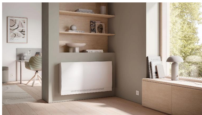
Sl. 3-10: Ventilokonvektor u niskotemperaturnom sustavu grijanja (npr. s dizalicom topline)
