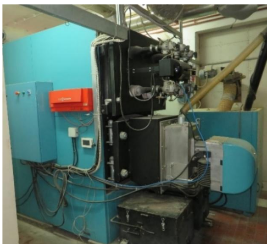
Sl. 3-24: Kotao na biomasu u kotlovnici višestambene zgrade u Vukovaru (lijevo) i modularni kondenzacijski plinski kotao toplane u Rijeci (desno)
